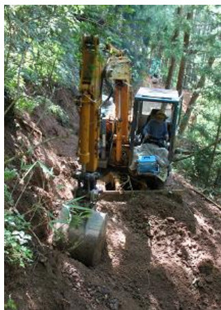
作業路開設風景
