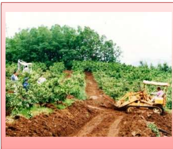
みかん園に農道を設置する作業風景
