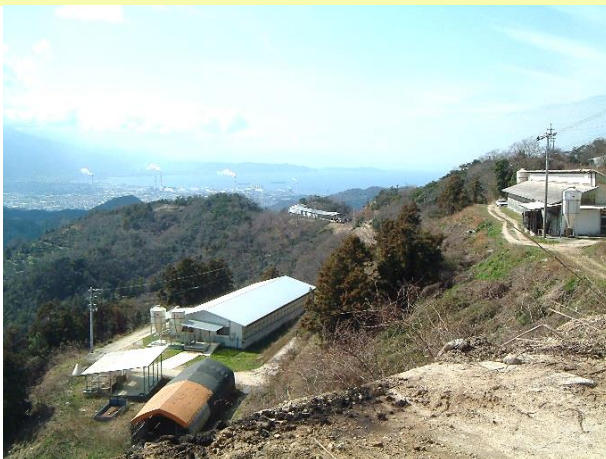
標高 300mの土地に建つ養豚場
